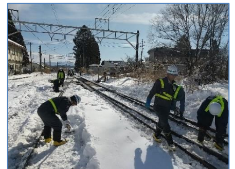
・黒姫駅構内除雪作業
